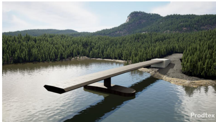
Figur 7-4: Eksempel fra Halsafjorden flytebru, landkar øst med startelement, klar for installasjon av flytebrustreng
